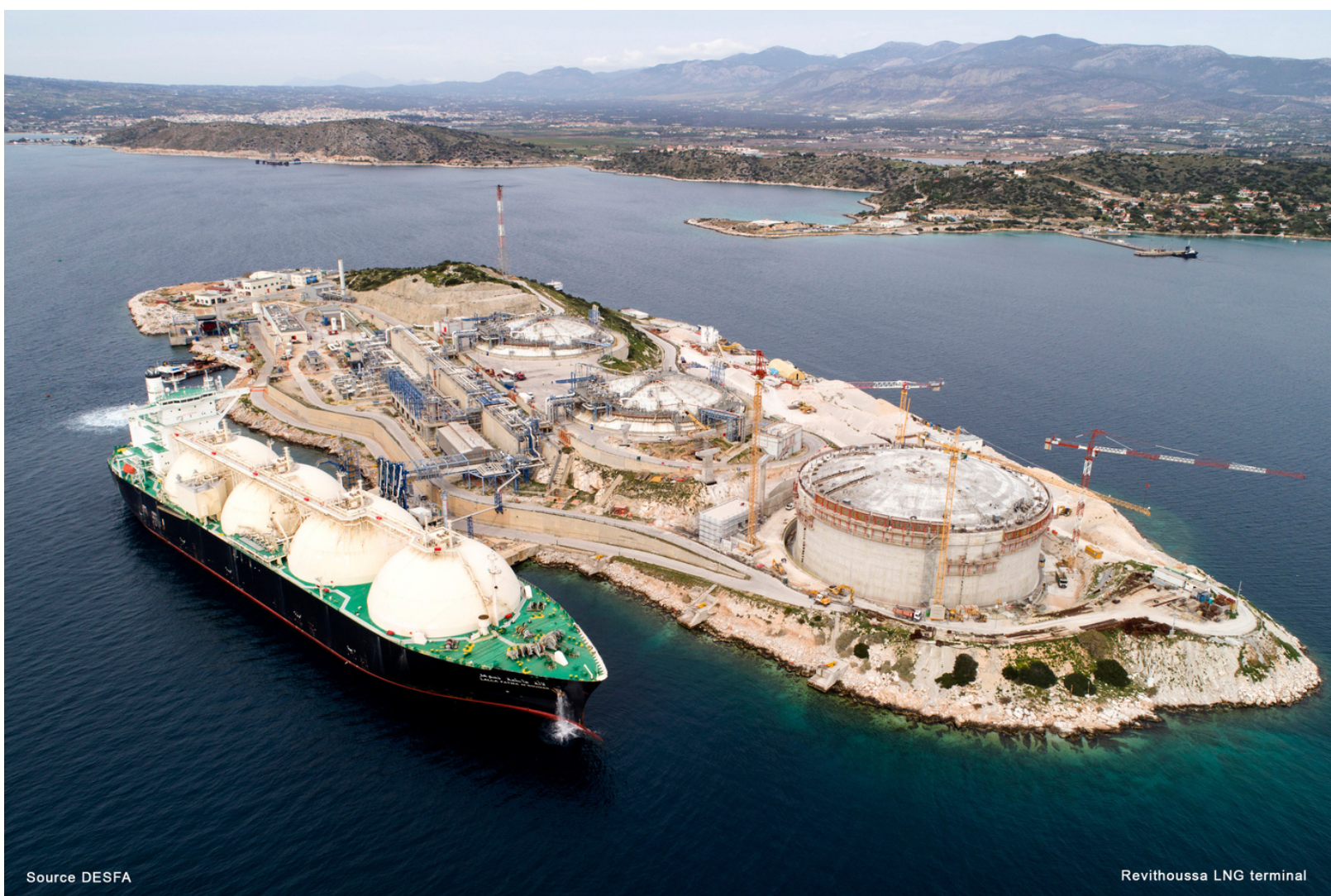
The Revithoussa LNG Terminal Source: DESFA
